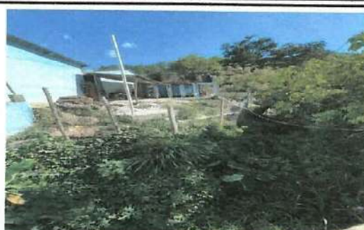
Foto 2: Pone en riesgo la vida de los estudiantes del establecimiento debido a que no contamos con muro de contención.
