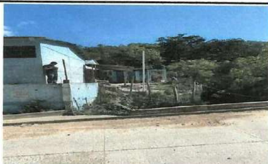
Foto 3: Esta es la realidad del establecimiento y demuestra que hace falta apoyo del MINEDUC para contar con un establecimiento digno y que el cierre perimetral debe ser completa.
